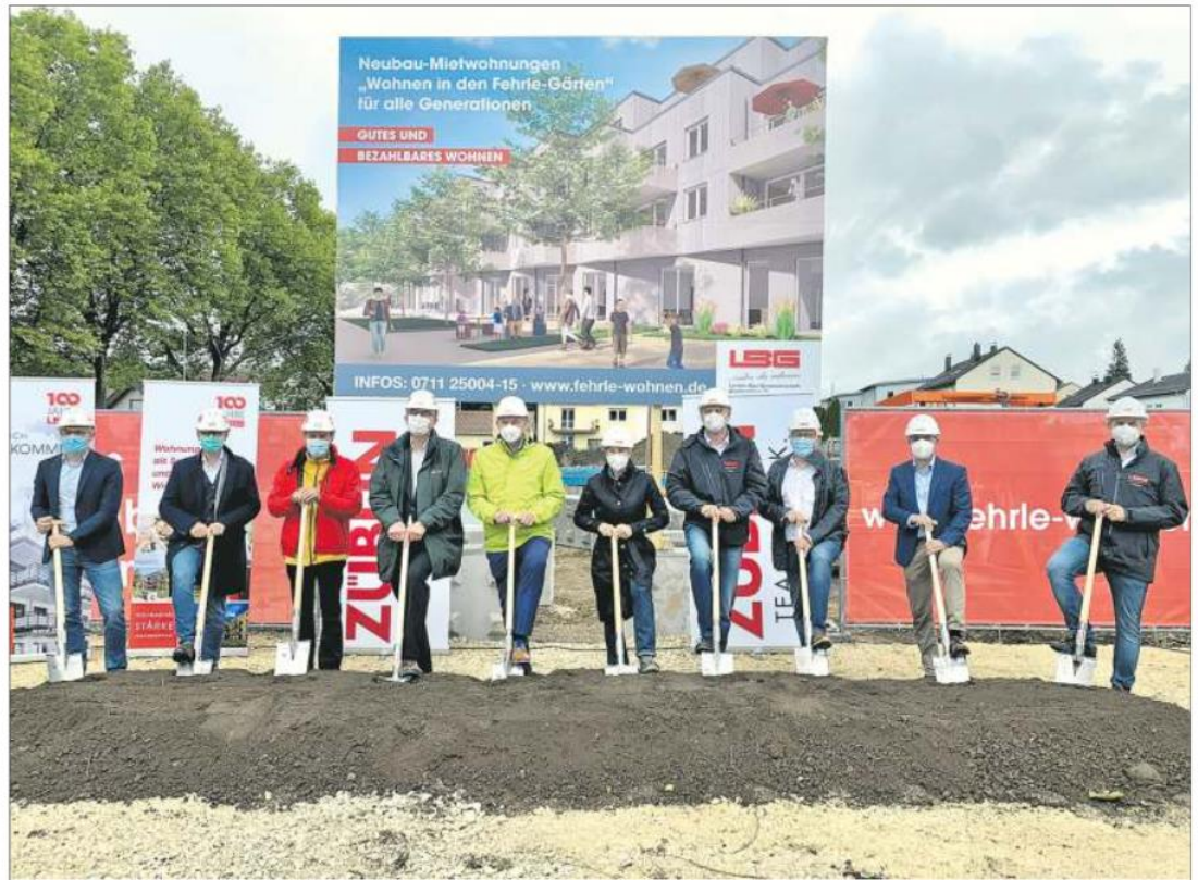
Am Montag fand der feierliche Spatenstich statt.
