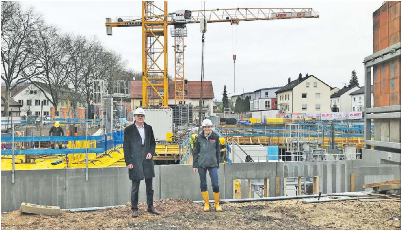
Im Oktober war Baubeginn. Hinten links im Bild sind schon die ersten Mauerziegel zu erkennen. Antje Durach und Josef Vogel sind mit dem Baufortschritt zufrieden. Die Fehrle-Gärten sind das größte Projekt in der Geschichte der Landesbaugenossenschaft Stuttgart.
